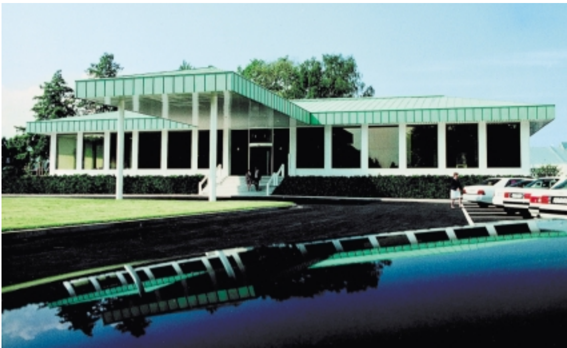
Das Woco-Kommunikationszentrum in Bad Soden-Salmünster
